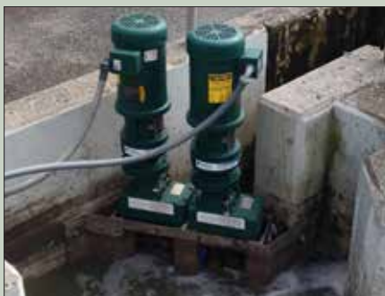
Individualiai pritaikytas montavimo rėmas
